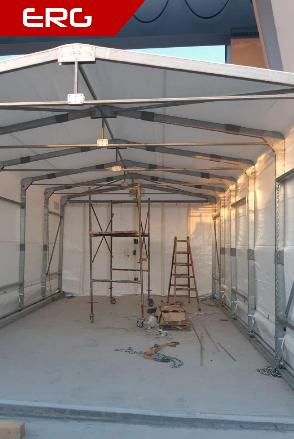
Εσωτερικό του κτιρίου.
