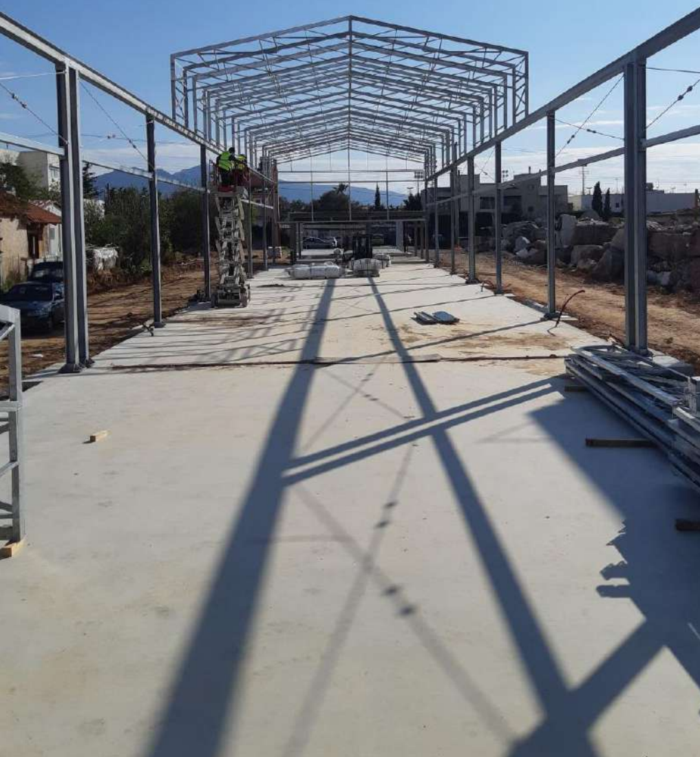
Σκελετός μεταλλικής κατασκευής με κινητή οροφή.
