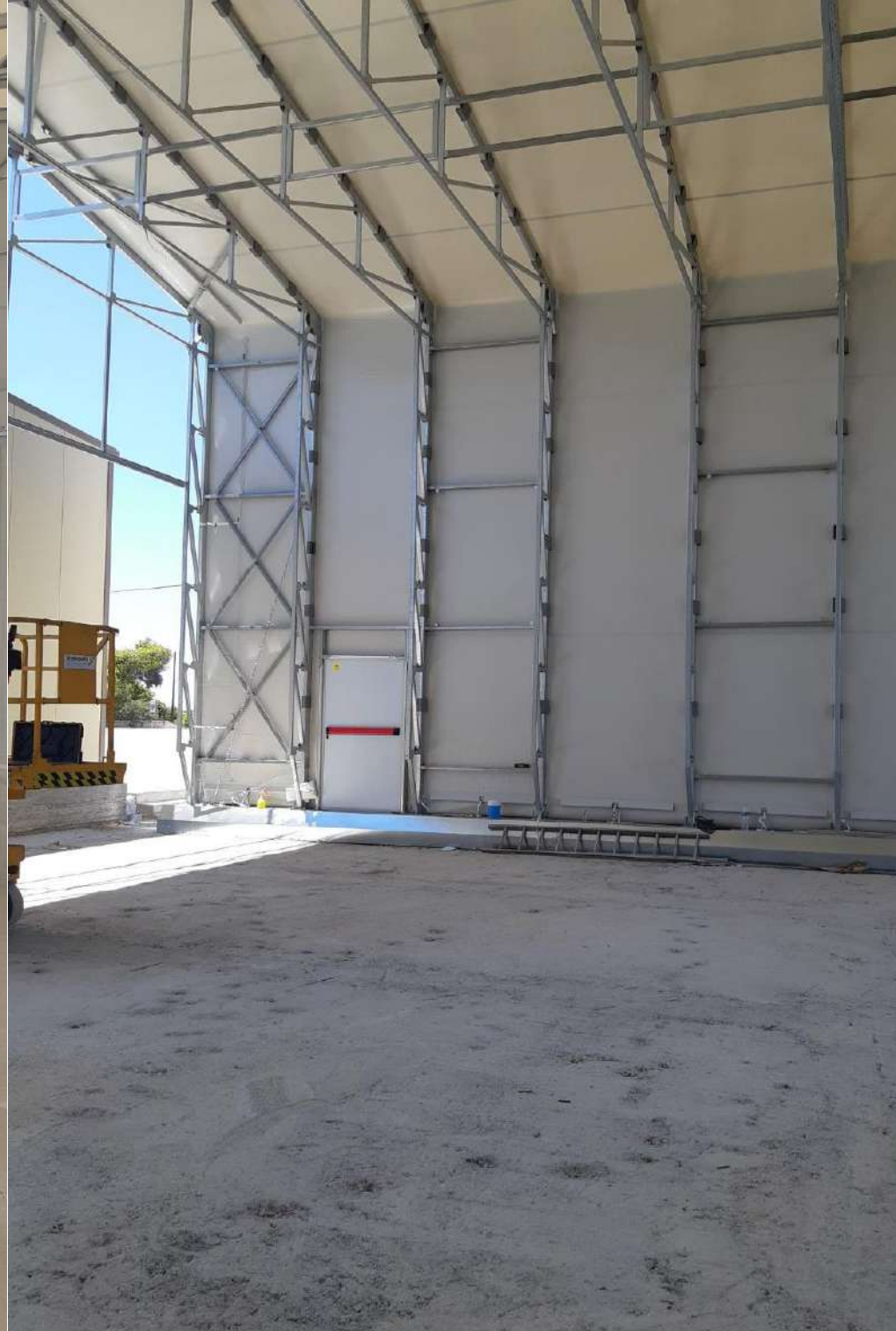
Εσωτερικό του κτιρίου, με την πόρτα ασφαλείας.
