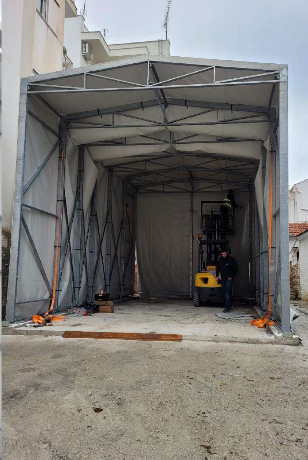
Μπροστινή άποψη της κατασκευής.
