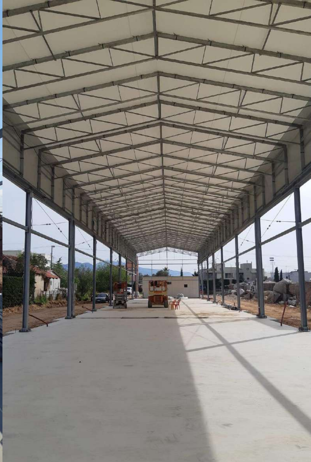
Εσωτερικό του υπόστεγου με το κάλυμμα PVC τοποθετημένο.
