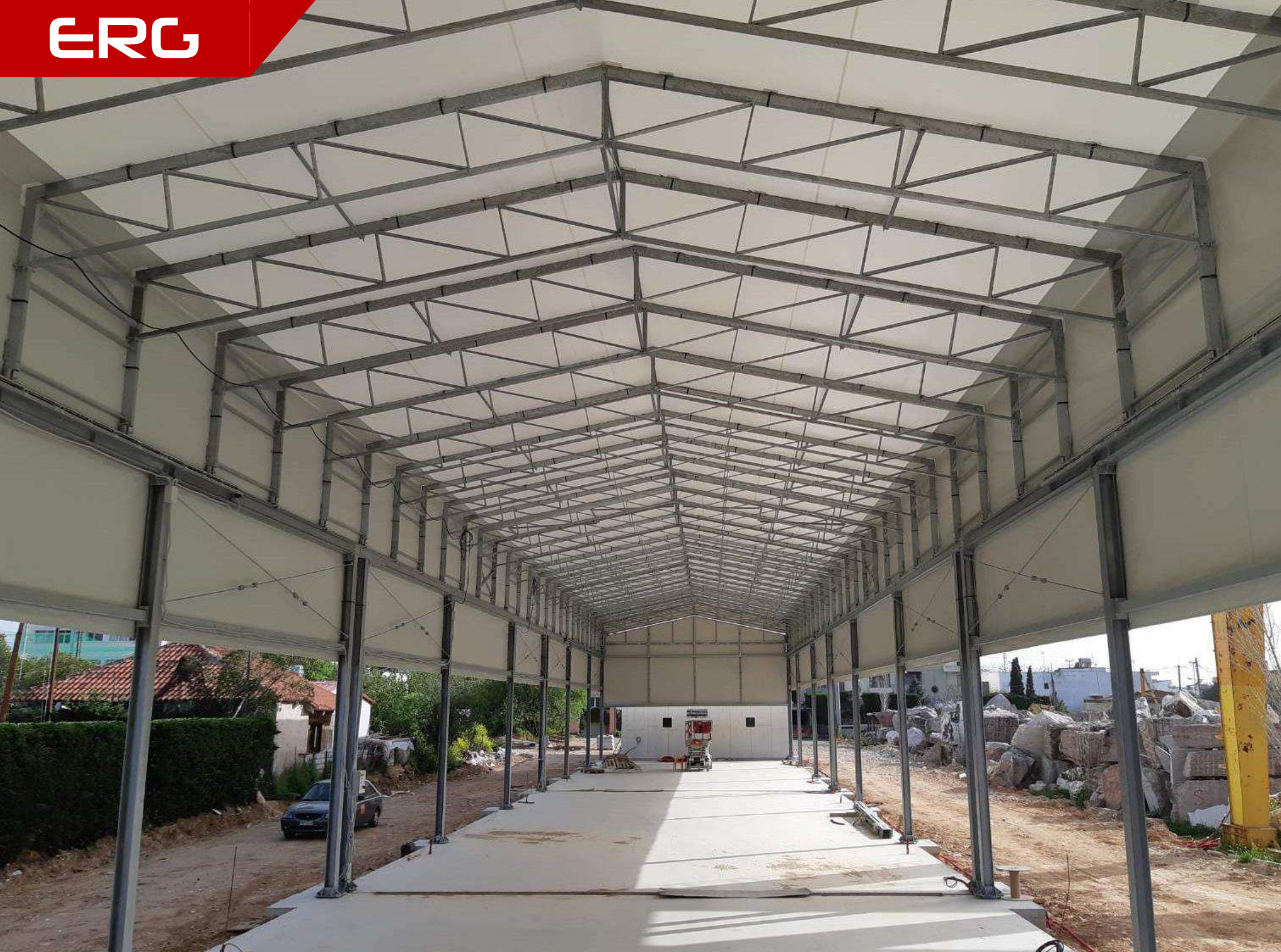
Λεπτομέρεια των κινητών μπλοκ της στέγης.
