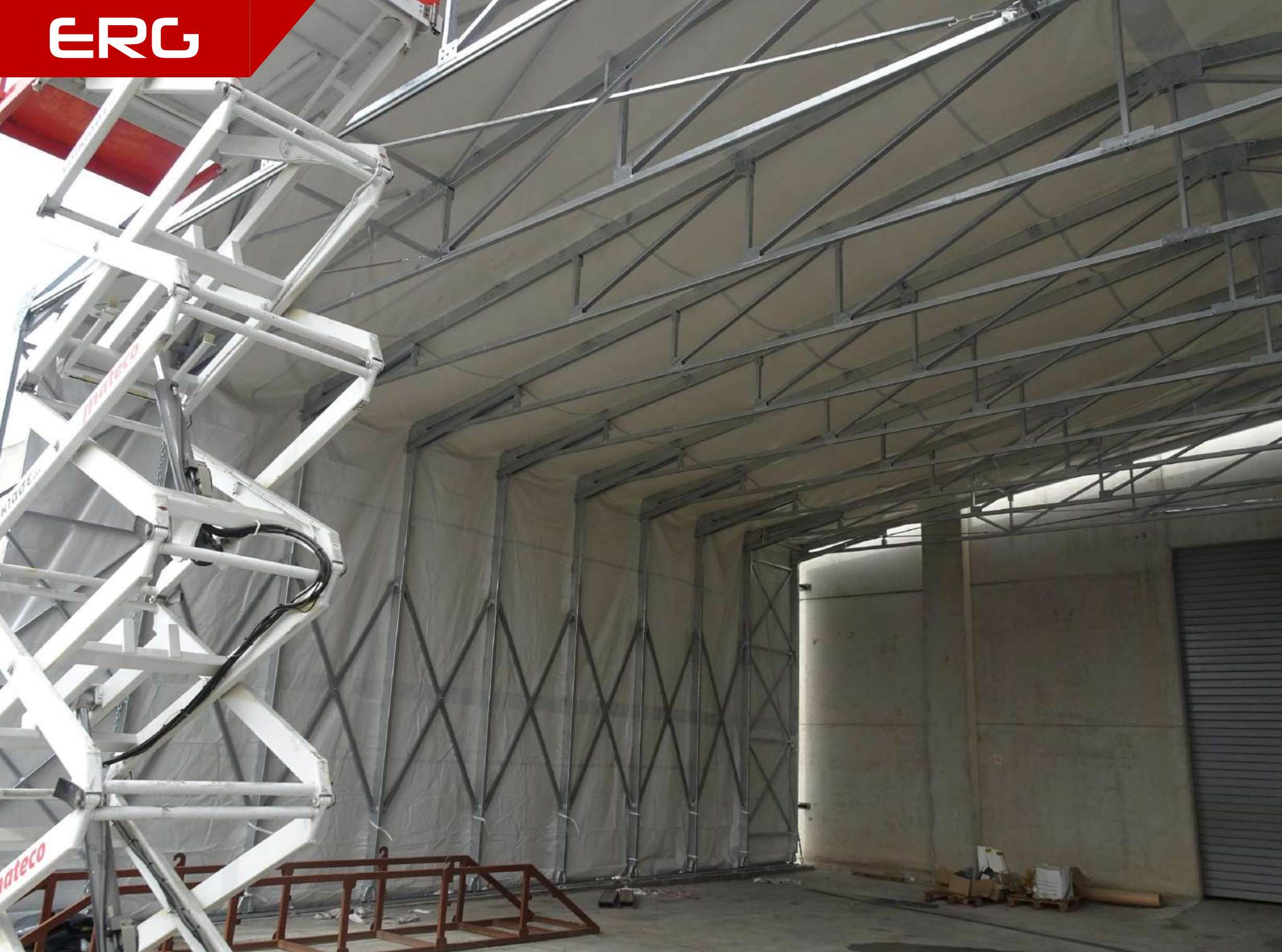
Εσωτερικό του κτιρίου. (Υπό κατασκευή)
