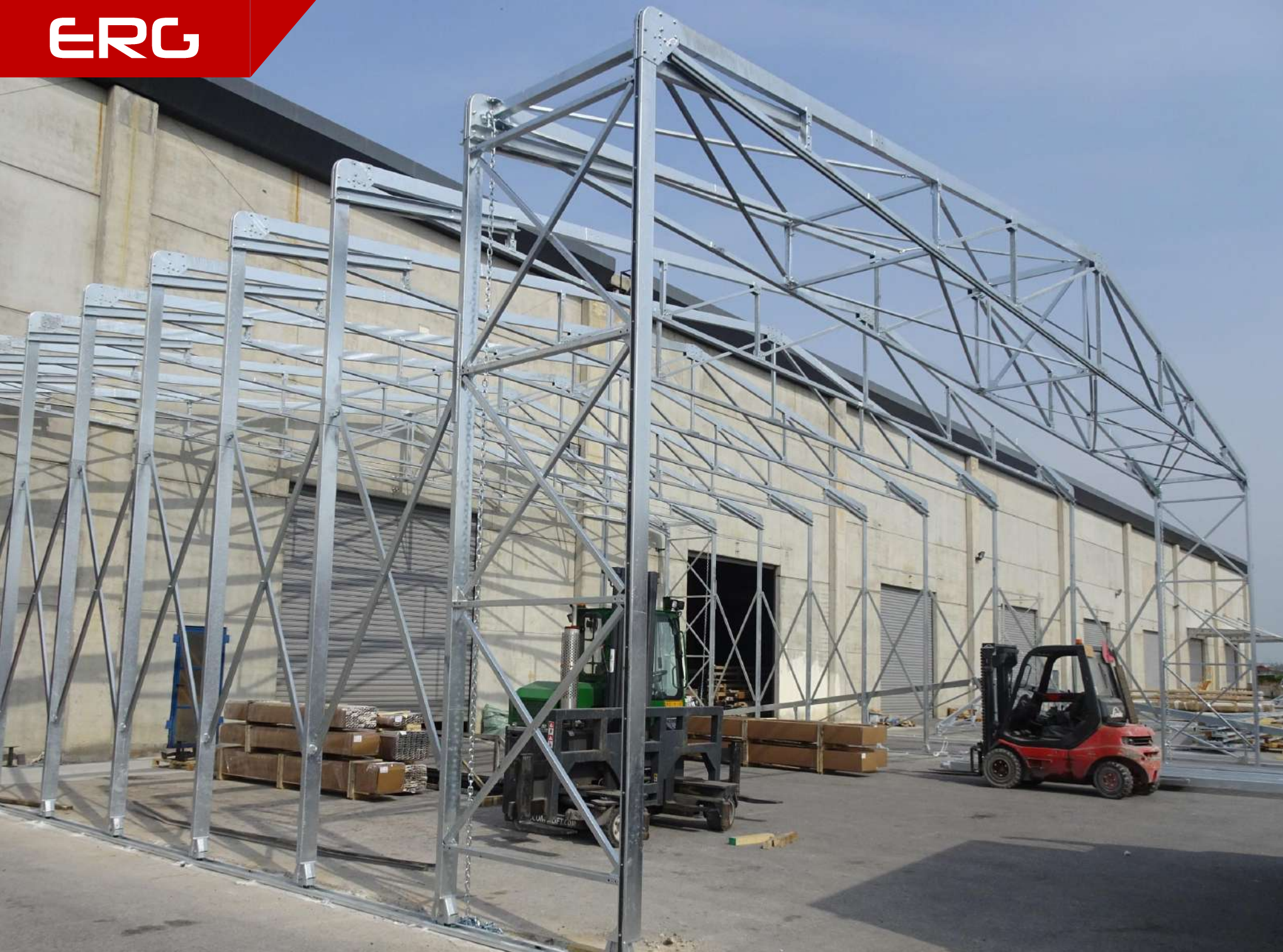
Πλαίσιο κατασκευής από χάλυβα.
