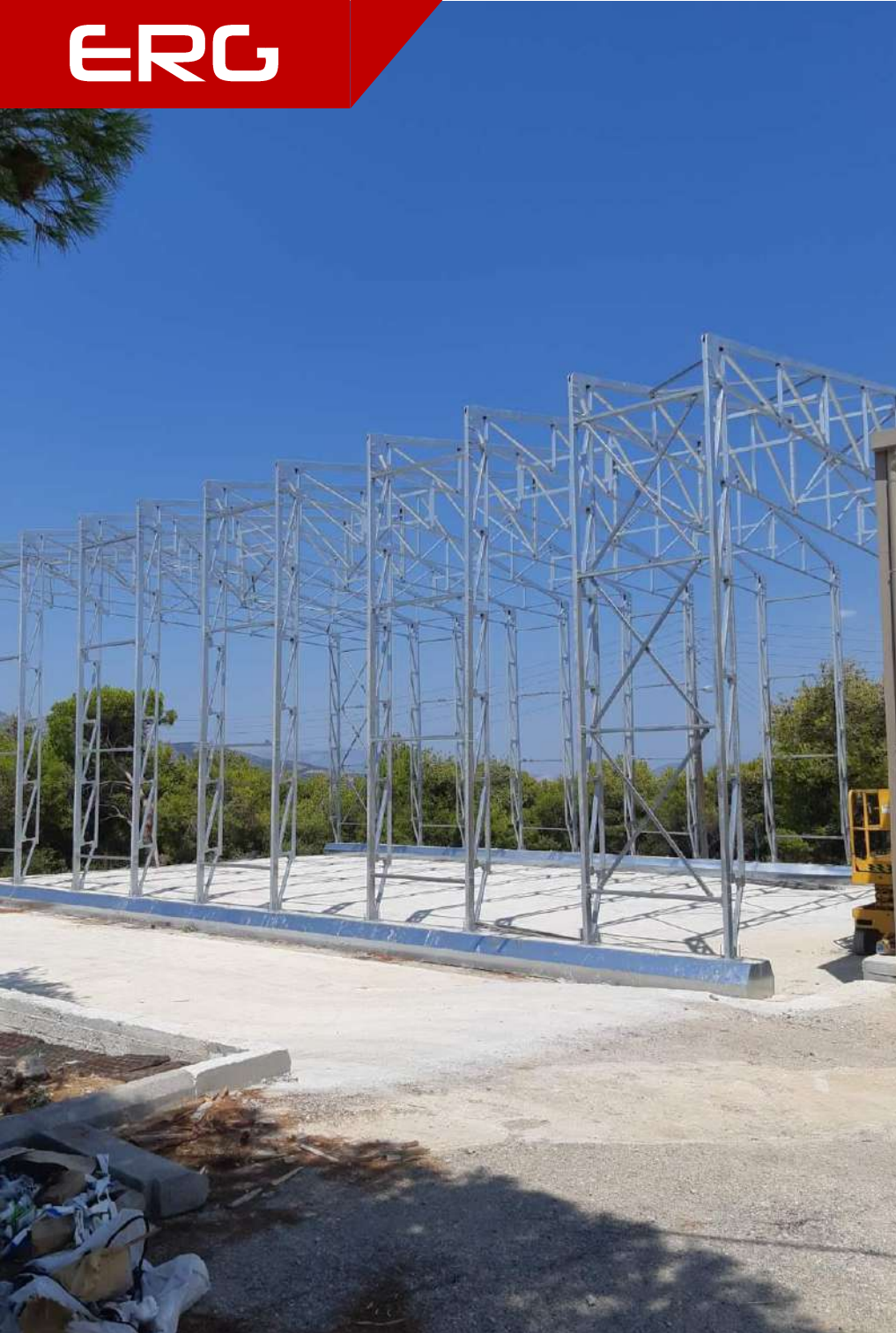
Πλαίσιο κατασκευής από χάλυβα.
