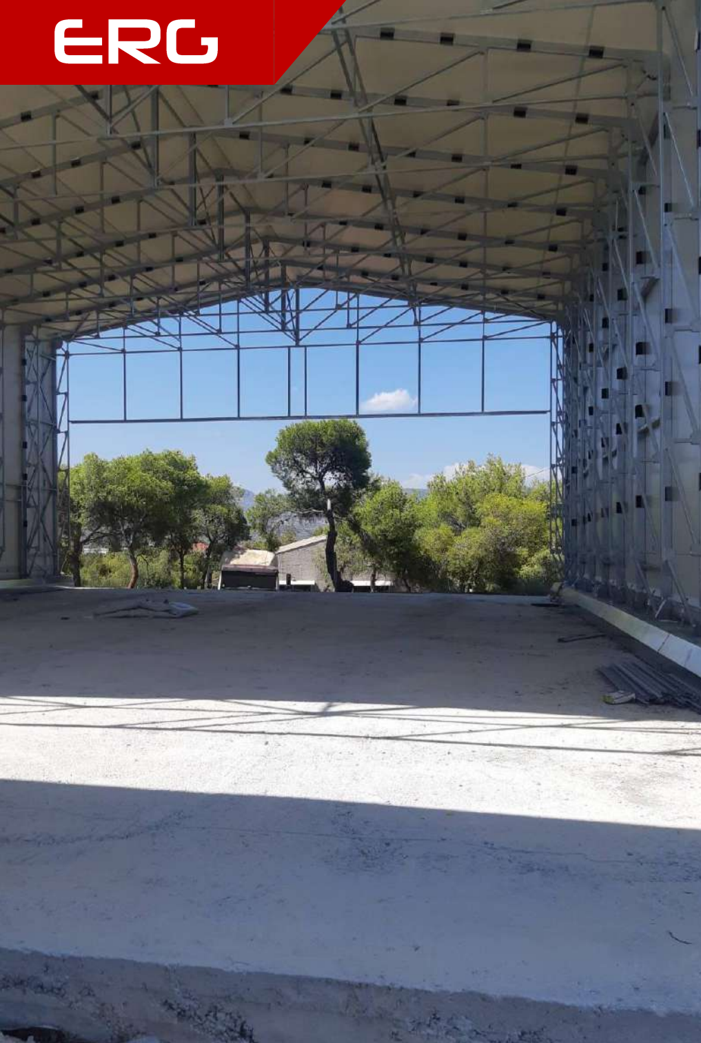
Εσωτερικό του κτιρίου. (Υπό κατασκευή)
