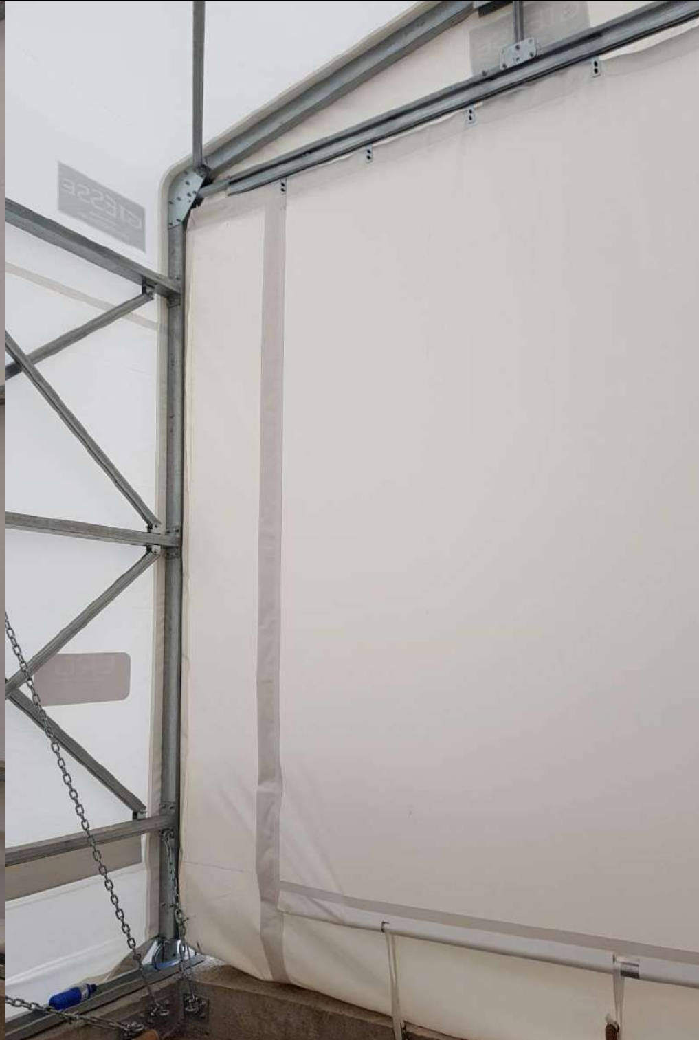
Όψη της συρόμενης κουρτίνας και του συστήματος κίνησης.
