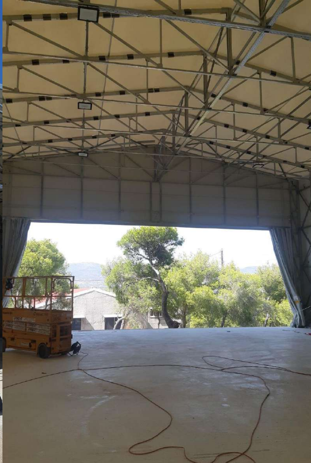
Εσωτερικό του κτιρίου. (Υπό κατασκευή)
