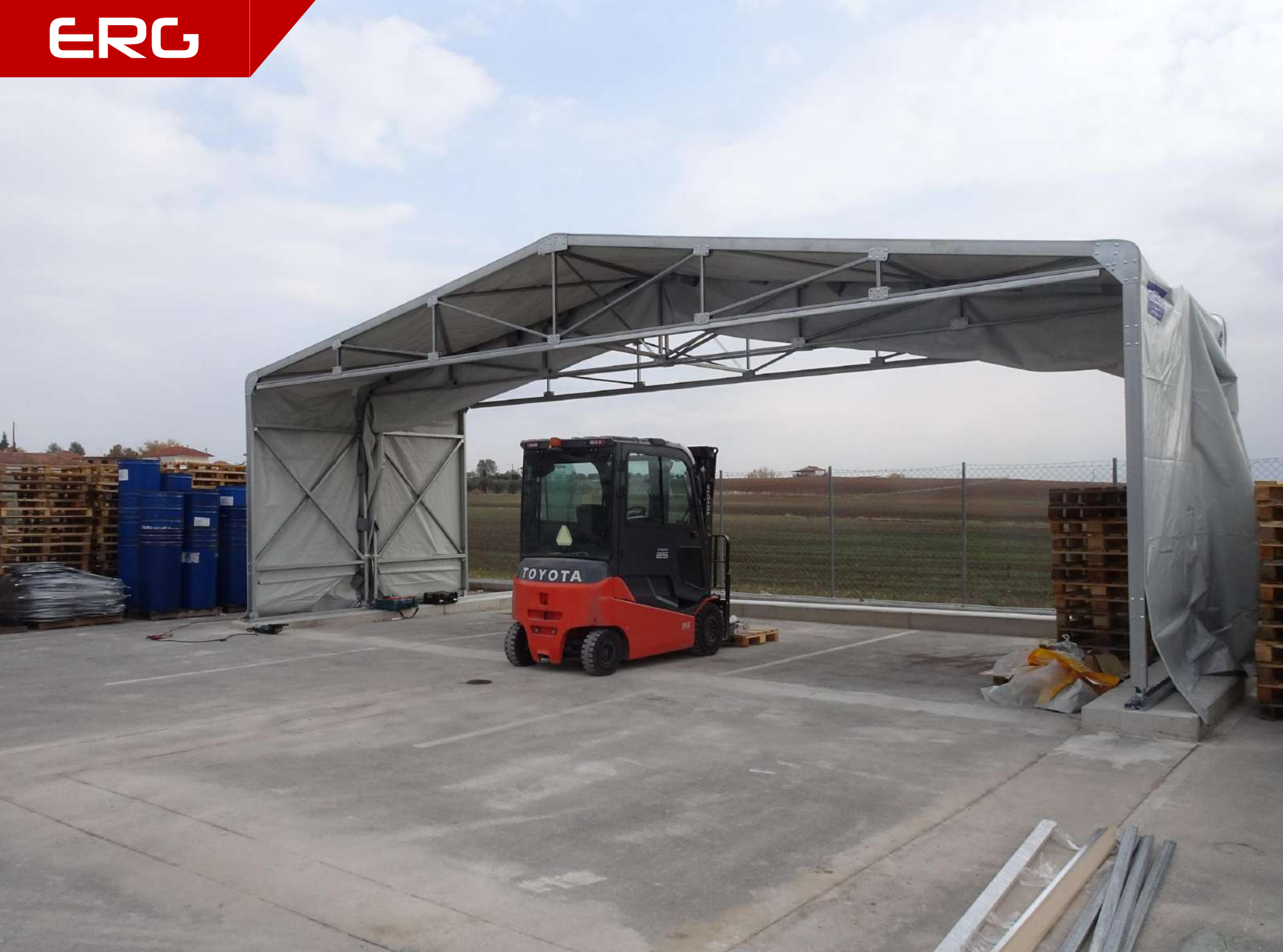
Όψη του κτιρίου σε «κλειστή» θέση. (Υπό κατασκευή)
